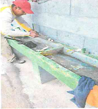
Foto1: Lavamanos sustitución de tubería y de 8 chorros.
