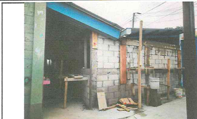
Foto1: Muro de block con repello, cernido y pintura
