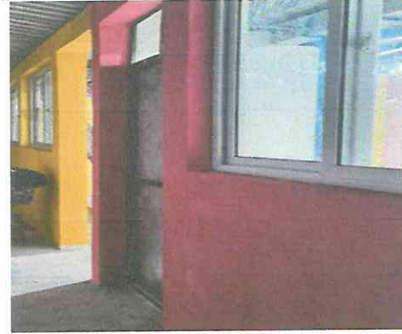
Foto 2: Sustitución de baranda de madera por puertas de metal.
