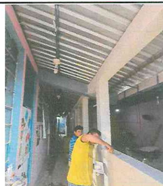
Foto 2: Instalación de ventana Pvc y vidrios de 1.80 metros x 1.50 metros.
