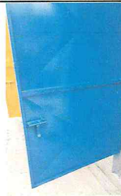
Foto 4: Mantenimiento de puertas sustitución de pasadores y pintura de interior y exterior de las puertas.
