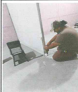
Foto 6: Sustitución de cancel de madera, por división de madera móvil de 2.80 metros X 2.35 metros.
